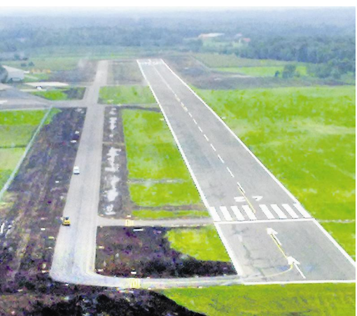
Die von 900 auf 1500 Meter verlängerte Start- und Landebahn am Flugplatz Schwarze Heide ist fertiggestellt. Aber Firmen wollen sich dort offenbar nicht ansiedeln. RN-Foto Steffe
