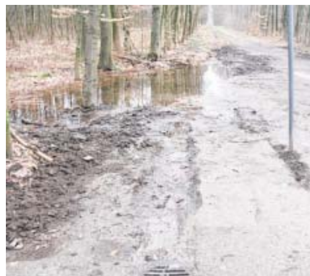
Pfützen bilden sich immer wieder nach der Verrohrung des Bachlaufes, wie hier an der Ecke Vossundern/Prozessionsweg.
